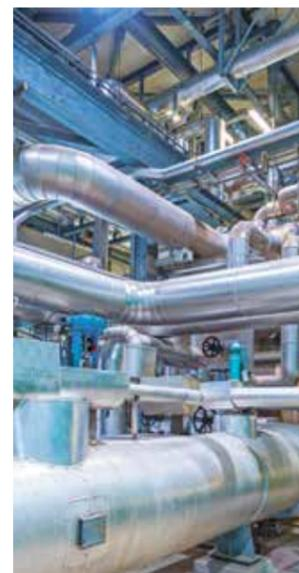
Sämtliche Apparate, Kolonnen, Behälter und Rohrleitungssysteme wurden geprüft. Zudem wurde die Zeit während des Stillstands genutzt, um Reparaturen, Reinigungen, Instandsetzungen, Wartungen und nicht zuletzt Arbeiten zur Verbesserung der Produktionsleistung sowie der Energieeffizienz
