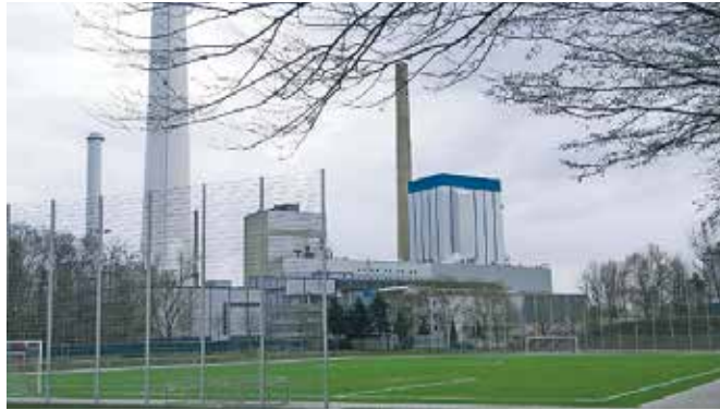
Auf dem Gelände des Heizkraftwerks Köln-Merkenich ist eine neue Anlage für die Verbrennung von Klärschlamm ab 2028 geplant.
