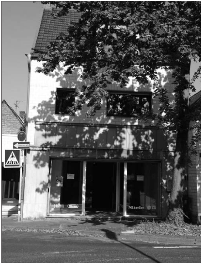
Hier entsteht in Kürze das Informationsbüro der StEB zum Retentionsraum Worringen. Das Ladenlokal im Hackhauser Weg 2 wird derzeit renoviert.
