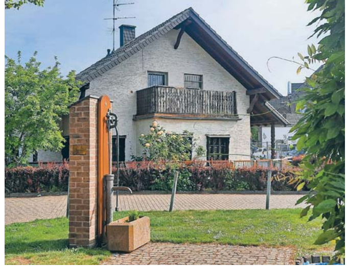
Das „Häuschen“ vor der Entkernung
