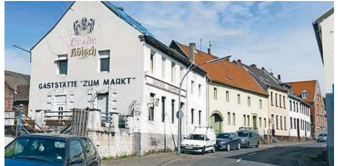
Im großen Stil saniert und denkmalgerecht umgebaut. Die Kulisse Om Maat.
