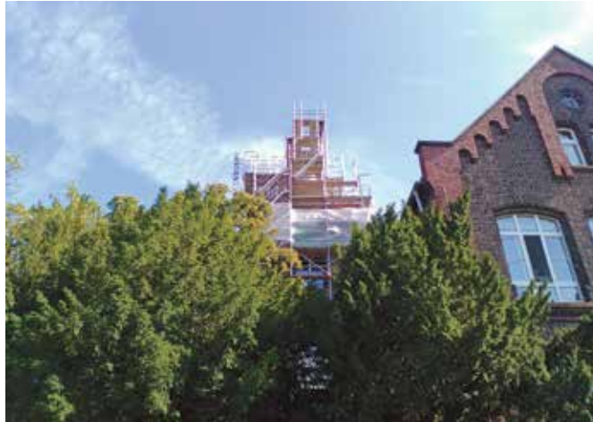
Kirchturm von Alt St. Pankratius eingerüstet für die Dachsanierung
