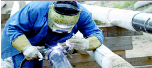
Umschlussarbeiten an den Versorgungsleitungen
