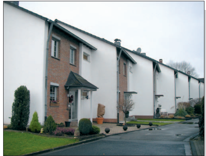
Betroffene Häuser – bald ohne Heizung
