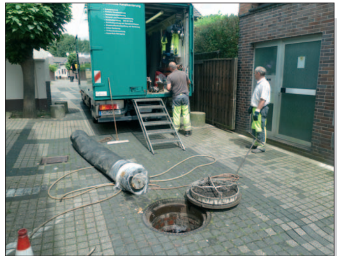
Herr Dressmer von der Fa. Kuchem und seine MA bei der Kanalsanierung in der Elkemannstraße mit fahrbarer Kamera zur Reparaturkontrolle
