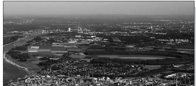
Retentionsraum „Worringer Bruch“
