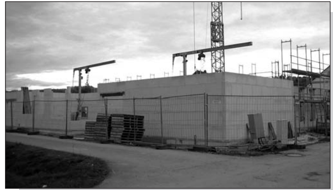
Noch prägen die Bauarbeiten das Bild.
