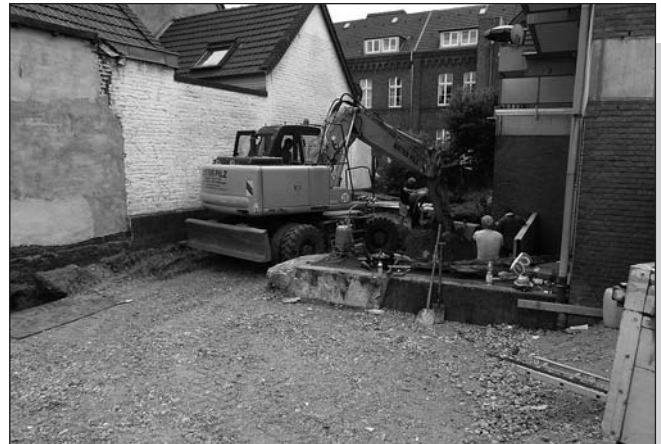
Der Bagger rollt und Worringen ist bald noch attraktiver.
