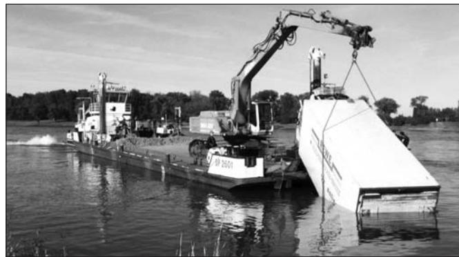
Volle Schubkraft Richtung Uferböschung am Wasserturm
