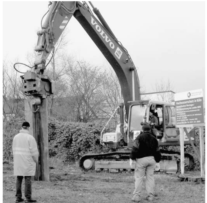
Der Bau gegen das 200jährige Hochwasser hat begonnen.
