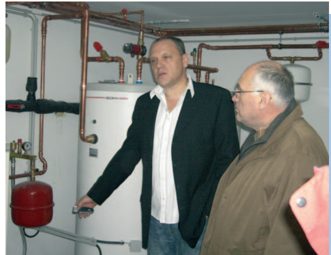
Architekt Schlimgen erläutert die Funktionsweise der Erdwärme-Anlage.
