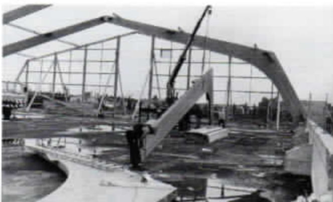
Die Tennisabteilung feiert am 11. September ihr Silberjubiläum. Hier ein Bild vom Bau der Tennishalle.
