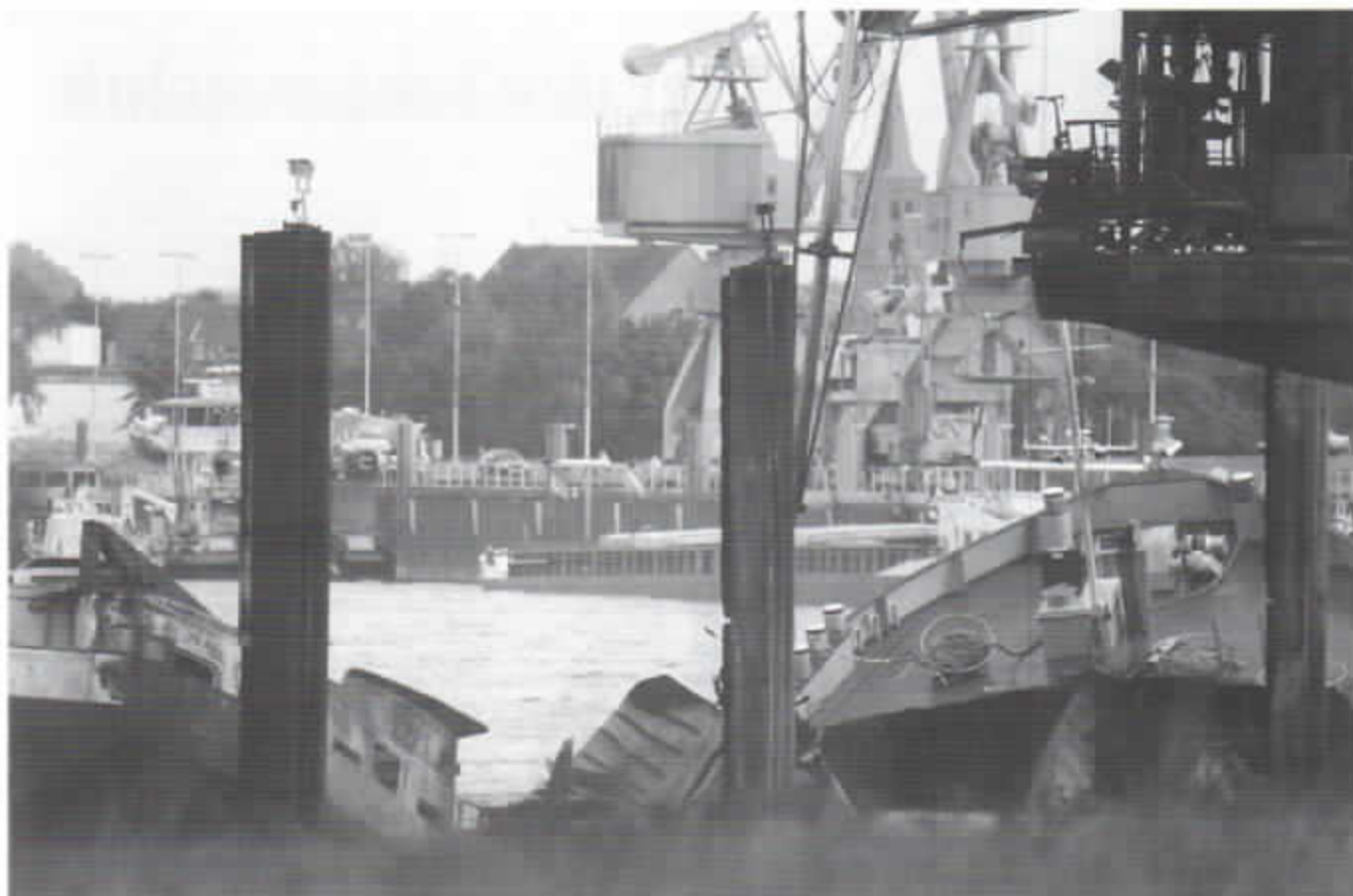
Am Morgen nach der Explosion ragt der Bug der „Avanti“ in Richtung Worringen. Das Schiff ist zu diesem Zeitpunkt immer noch mit der Tankerbrücke verbunden.
